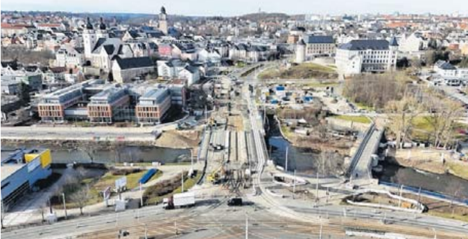
Der Bereich um die Neue Elsterbrücke ist zurzeit eine Großbaustelle, die Einschränkungen im Straßenverkehr mit sich bringt.
